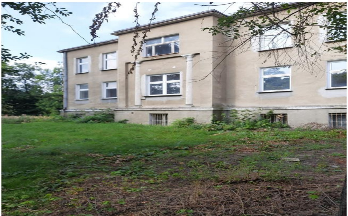
Fotografia 1 - Teren 1MW-U budynek byłej weterynarii obecnie nieużytkowany.
