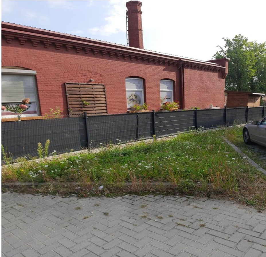
Fotografia 3 - Teren KP-ZP parking przy Domu weselnym.
