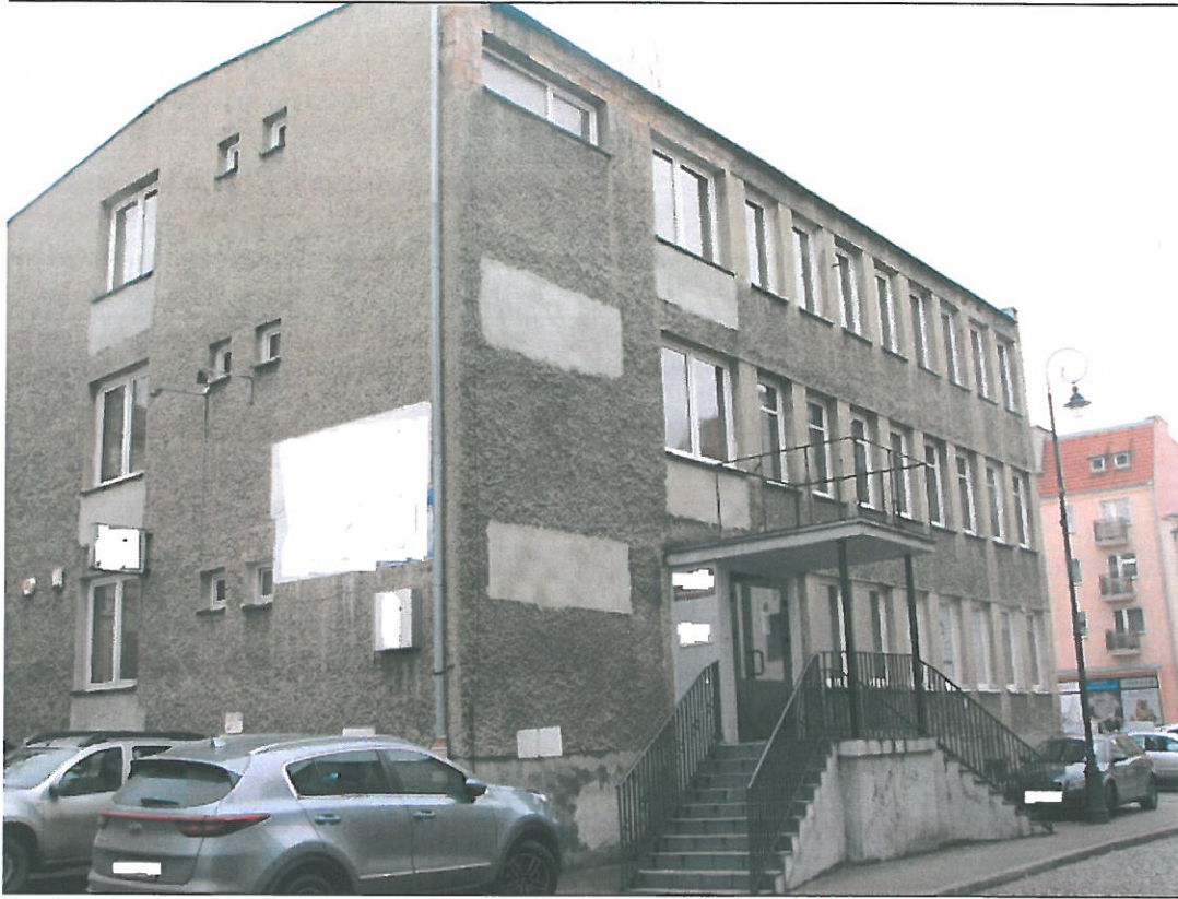
Budynek przy ul. Tkackiej nr 1, widok elewacji od frontowej i bocznej i bocznej.
