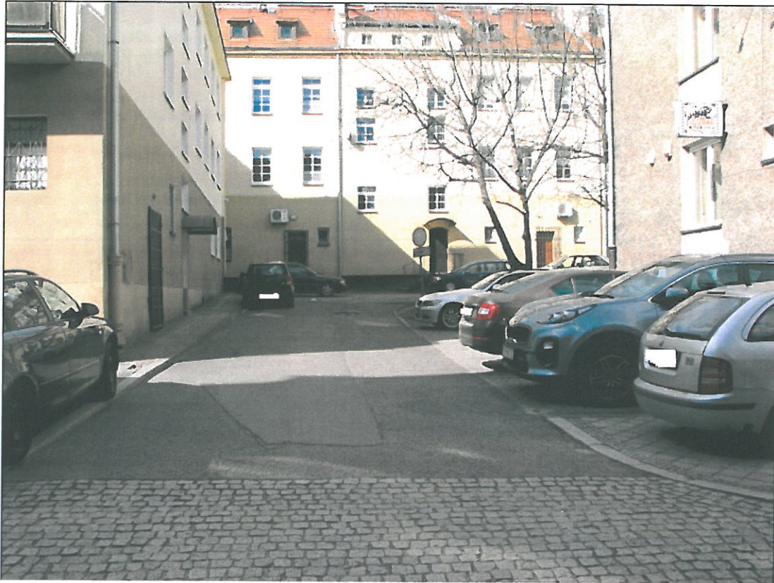
Widok na wjazd na teren za budynkiem (od strony ul. Sobieskiego).
