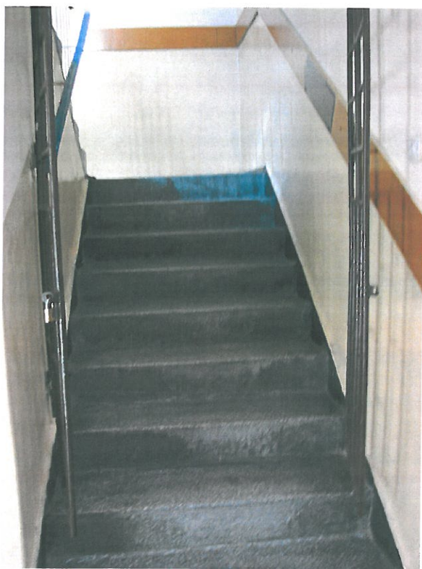
Klatka schodowa – wejście na I piętro
