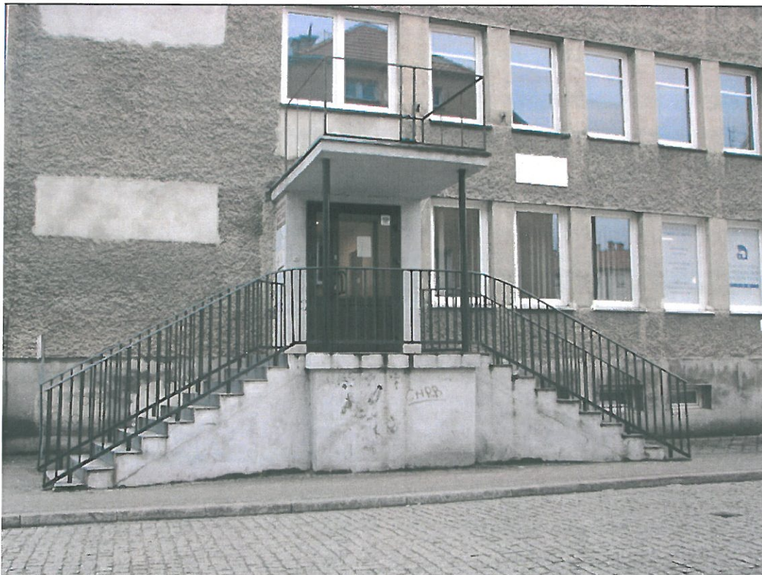
Wejście do budynku.
