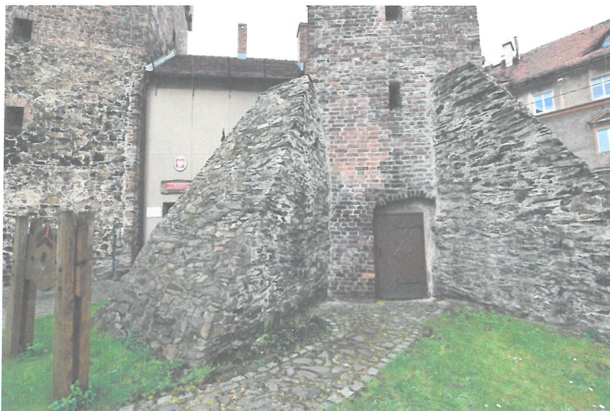
Fot. 2 Przypora północna (z lewej).
