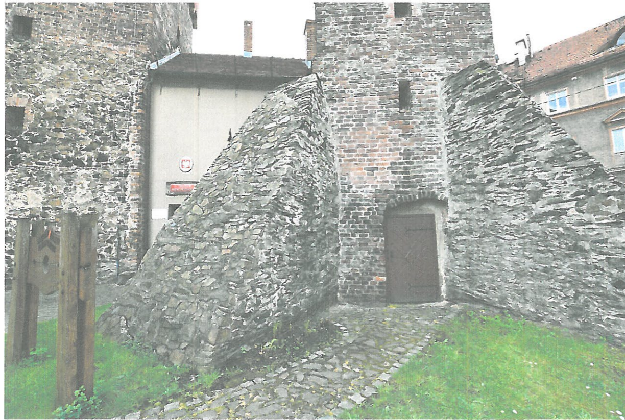
Fot. 2 Przypora północna (z lewej).
