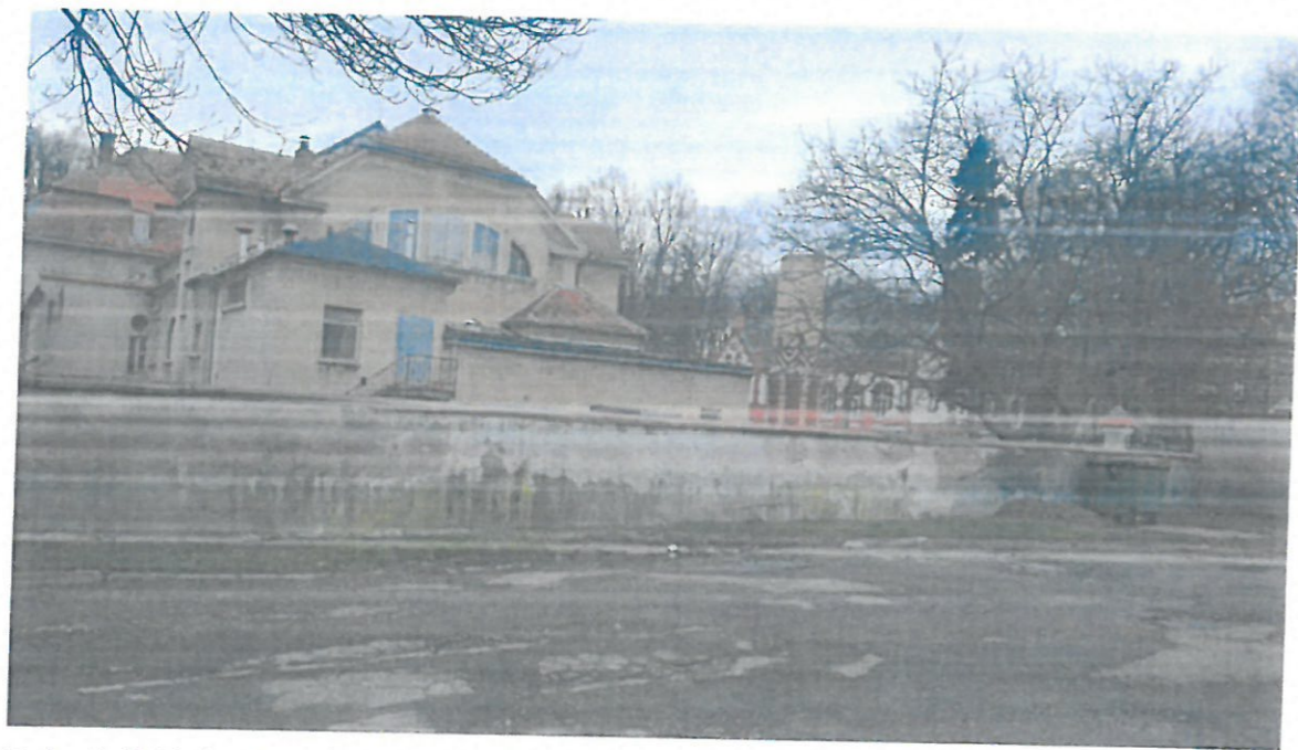
Fot. 6 Widok ogrodzenia od strony południowej, widok zabytkowego basenu krytego
