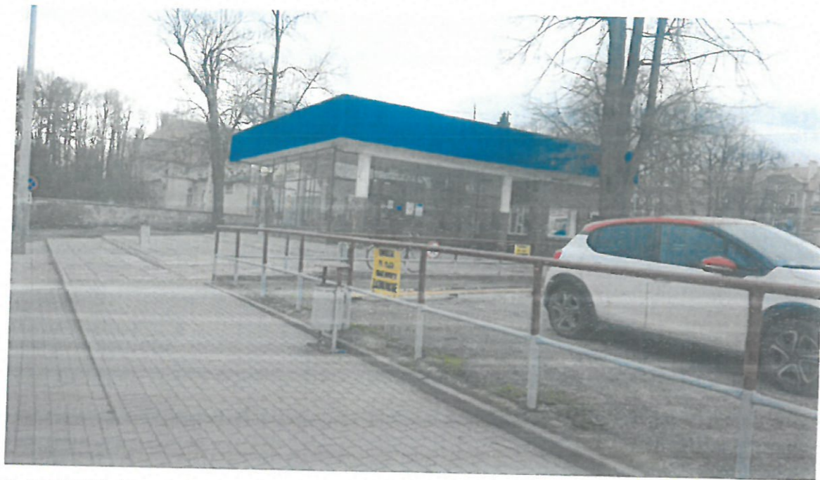
Fot. 5 Widok na istniejący budynek Dworca od ulicy Sądowej
