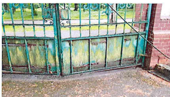
Fot. 27-46. Stan elementów metalowych
