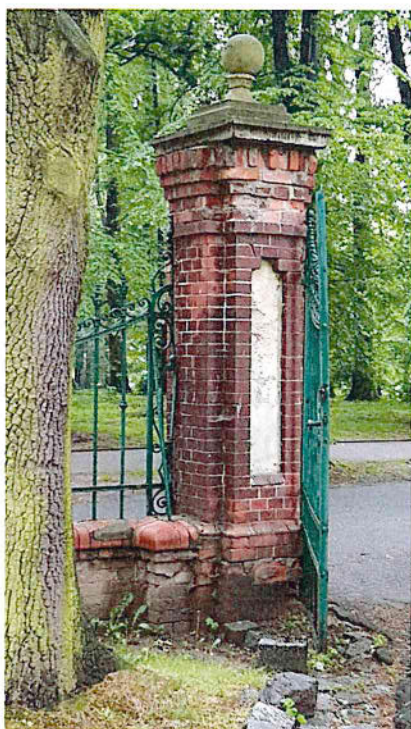
Fot. 11-16. Stan części cokołowej słupów
