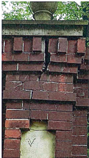
Fot. 2-10. Stan części cokołowej słupów
