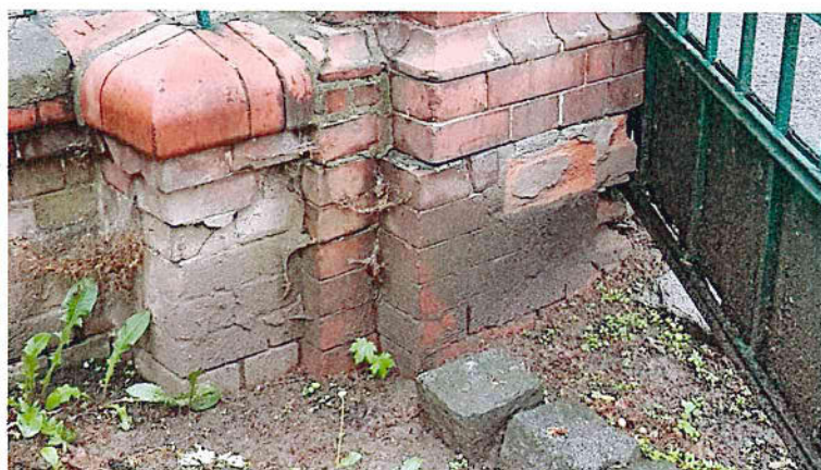
Fot. 11-16. Stan części cokołowej słupów
