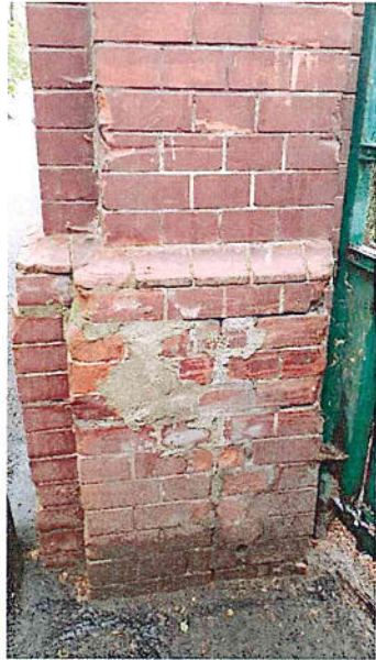
Fot. 2-10. Stan części cokołowej słupów
