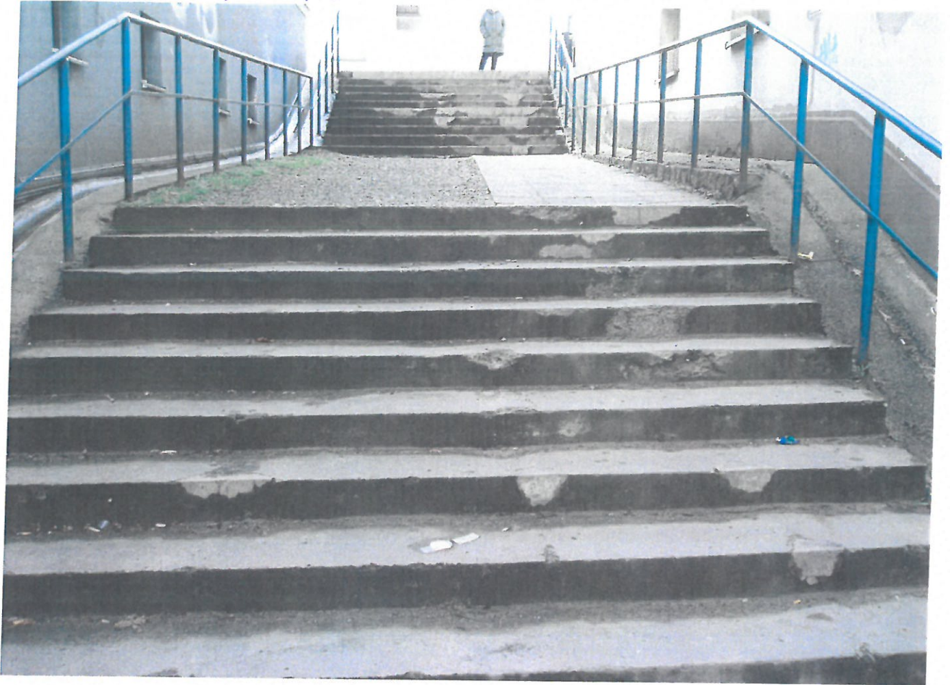
FOTOGRAFIE ISTNIEJĄCEGO STANU TECHNICZNEGO PRZY ULICY KRÓLOWEJ JADWIGI W PRUDNIKU
