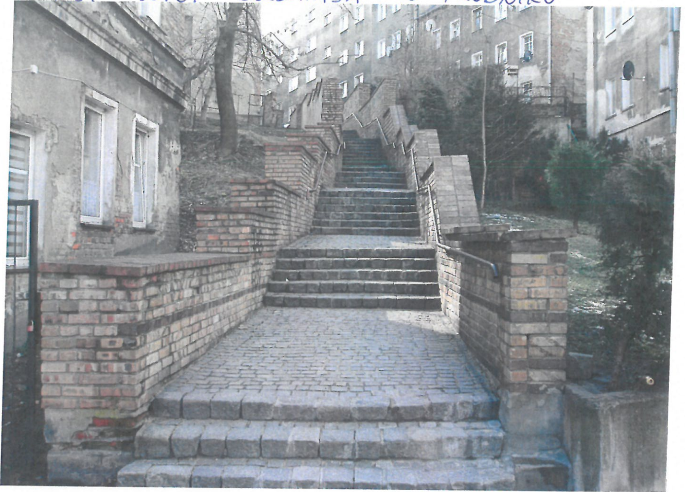
FOTOGRAFIE ISTNIEJĄCEGO STANU TECHNICZNEGO PRZY ULICY KOLEATAJA W PRUDNIKU
