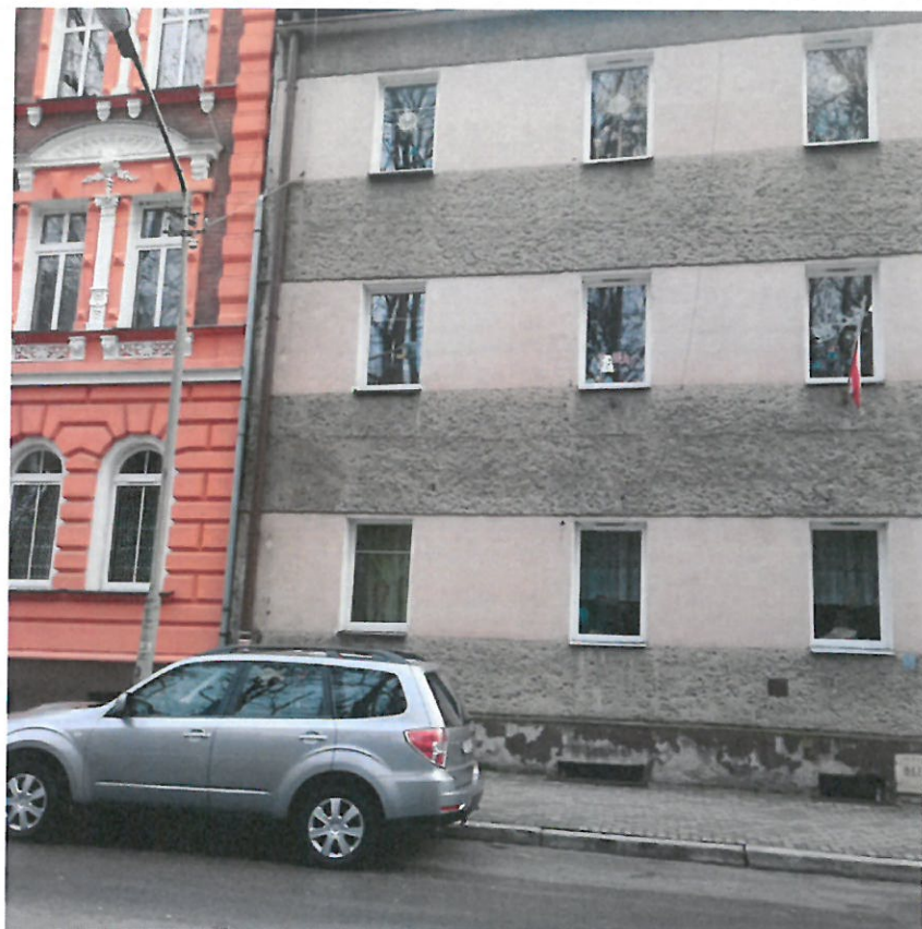
Elewacja zachodnia –od strony ulicy
