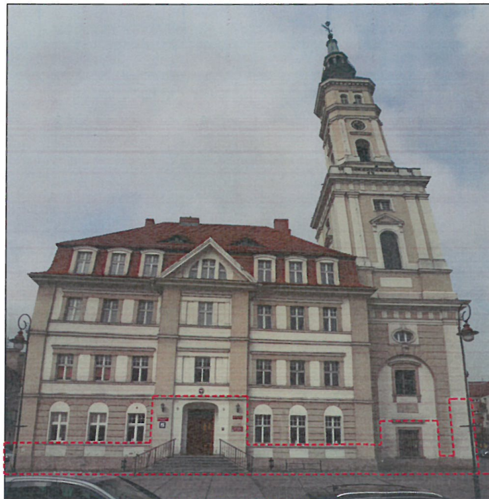
Część elewacji objęta opracowaniem (po obwodzie całego budynku) - malowanie
