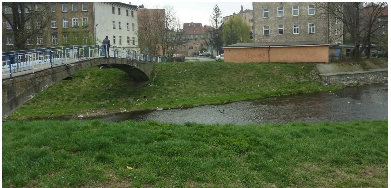
Rys. 1.2 Widok na kładkę obok, której jest planowane miejsce wykonania przeprawy tymczasowej
