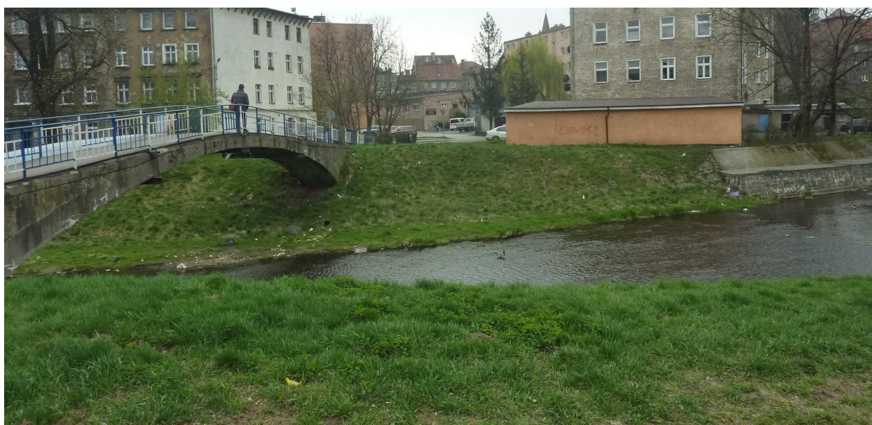
Rys. 1.2 Widok na kładkę obok, której jest planowane miejsce wykonania przeprawy tymczasowej
