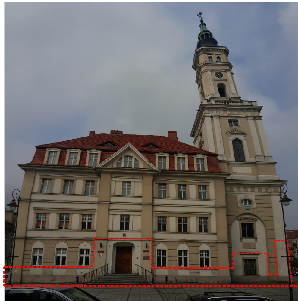
Część elewacji objęta opracowaniem (po obwodzie całego budynku) - tynki renowacyjne
