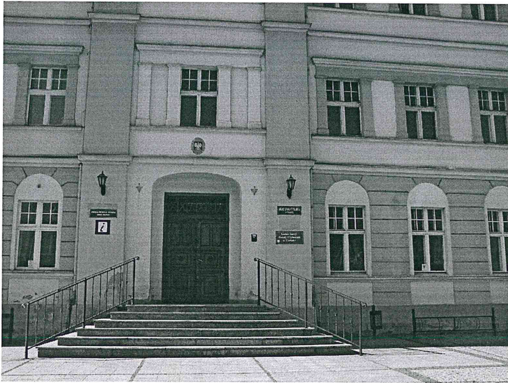
Wejście do budynku Ratusza schody wejściowe.
