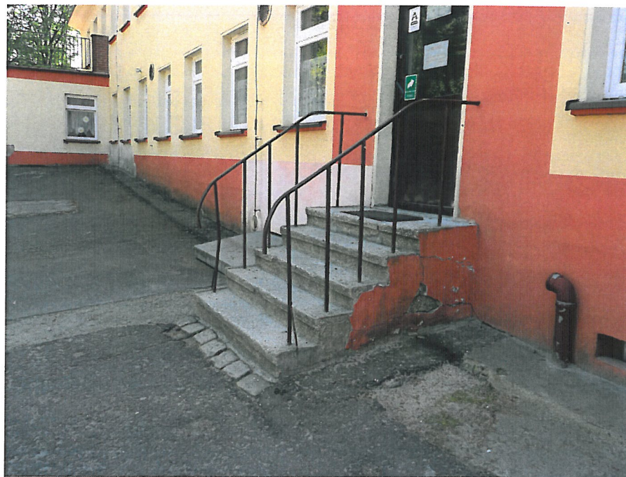
4. Schody zewnętrzne przeznaczone do remontu
