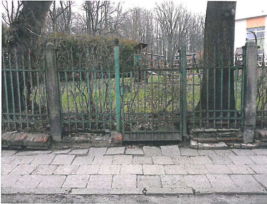
Zdjęcie. 3. Ogrodzenie istniejące - widok fragmentu ogrodzenia przeznaczonego do rozbioru
