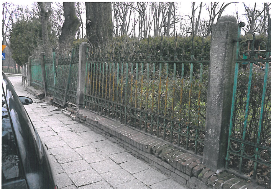
Zdjęcie. 1. Ogrodzenie istniejące - widok fragmentu ogrodzenia przeznaczonego do rozbiórki
