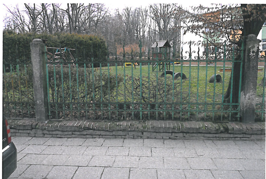
Zdjęcie. 2. Ogrodzenie istniejące - widok fragmentu ogrodzenia przeznaczonego do rozbiórki
