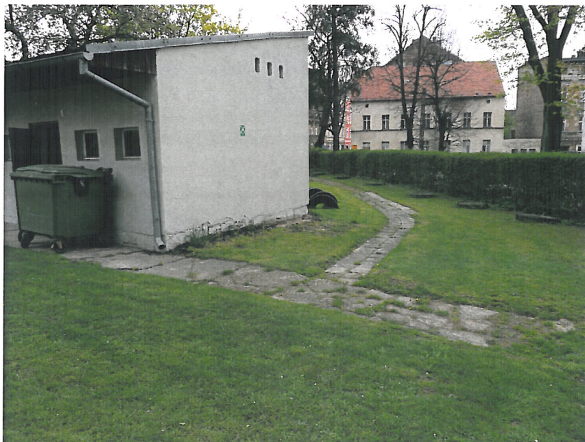
Zdjęcie. 5. Nawierzchnie przeznaczone do remontu
