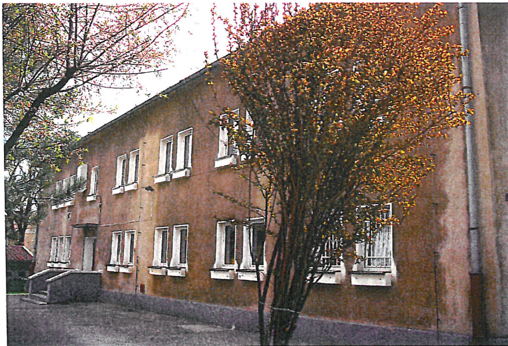
2. Elewacja północna (stan istniejący):
