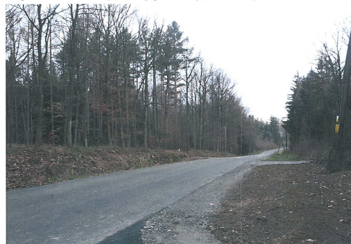
4. Napowietrzna linia SN w pasie drogi powiatowej (dz. nr 153/4)
