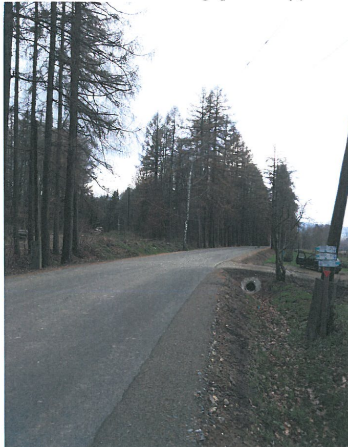
3. Napowietrzna linia SN na droga powiatową (dz. nr 155/4)
