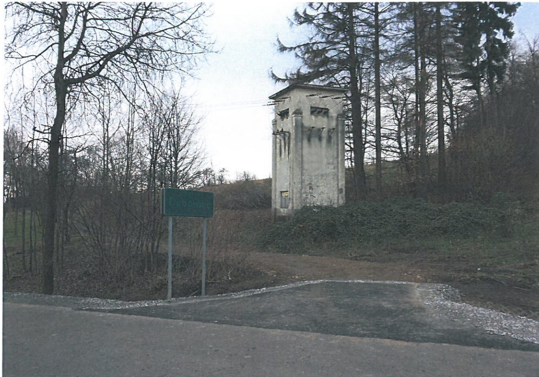
1. Stacja transformatorowa Dębowiec
