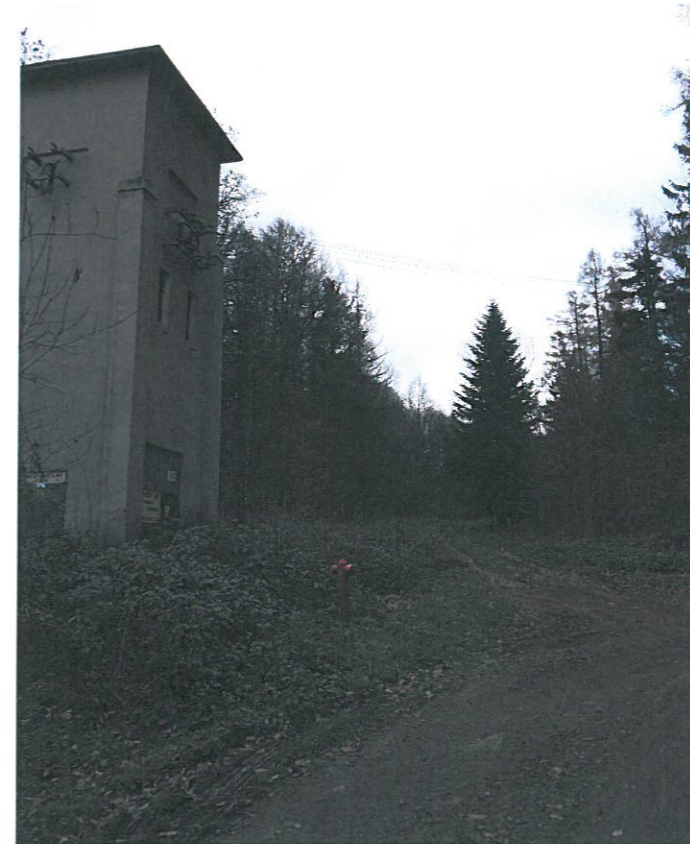
2. Stacja transformatorowa Wieszczyzna
