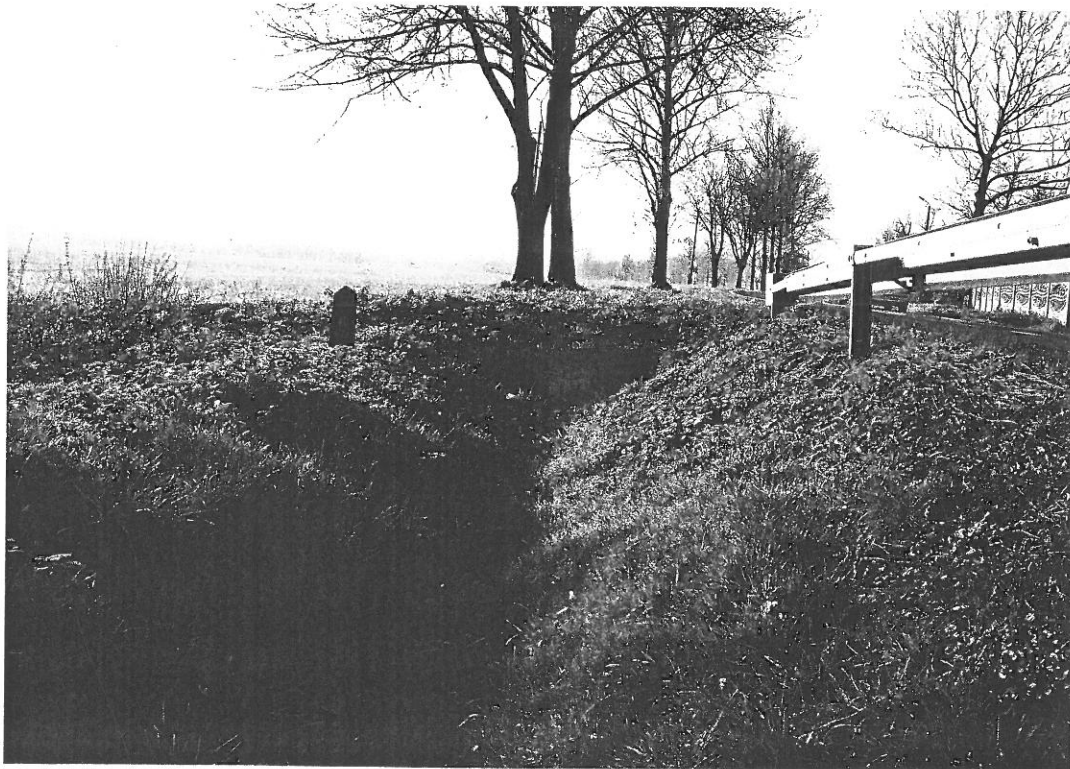
5. Przepust pod zjazdem na działkę nr 341.
