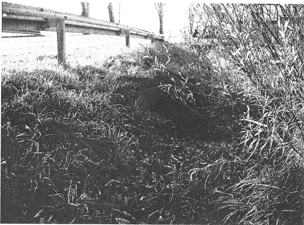
4. Przepust - widok z działki nr 330.
