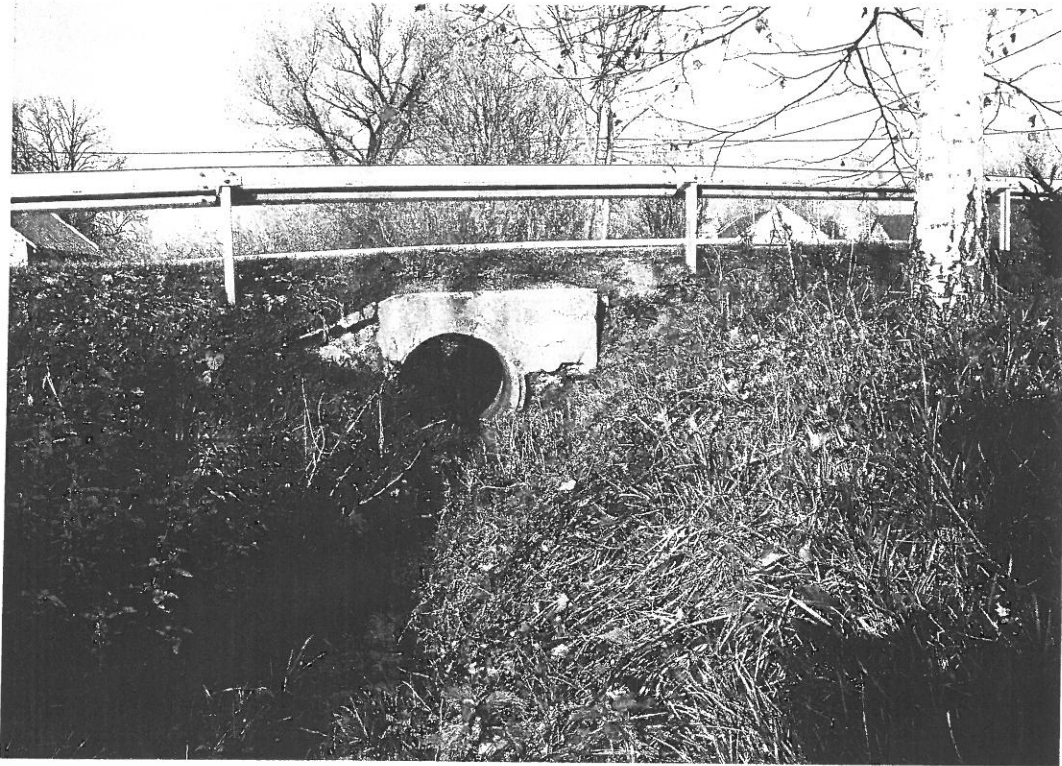
3. Przepust - widok z działki nr 342.
