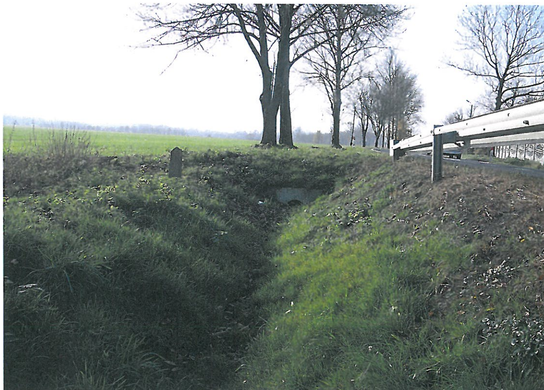
5. Przepust pod zjazdem na działkę nr 341.
