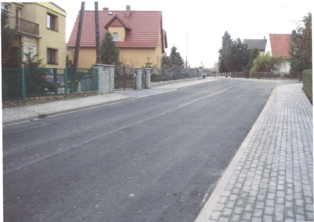
4. Przebudowa ul. Lompy
